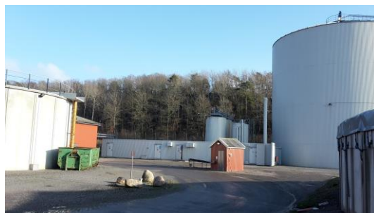
Biogasanläggningens sydvästra del, foto taget i sydlig riktning.
