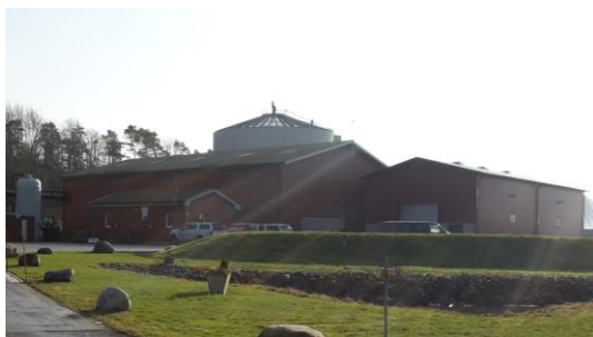
Biogasanläggningens nordöstra del, foto taget i sydlig riktning.
