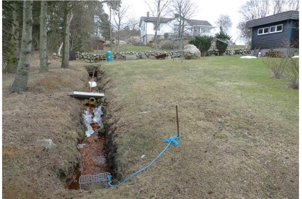
Bild 3.3: Öppet dike vid passage på fastigheten Ugglarp 1:32. Obs. järnutfällning.
