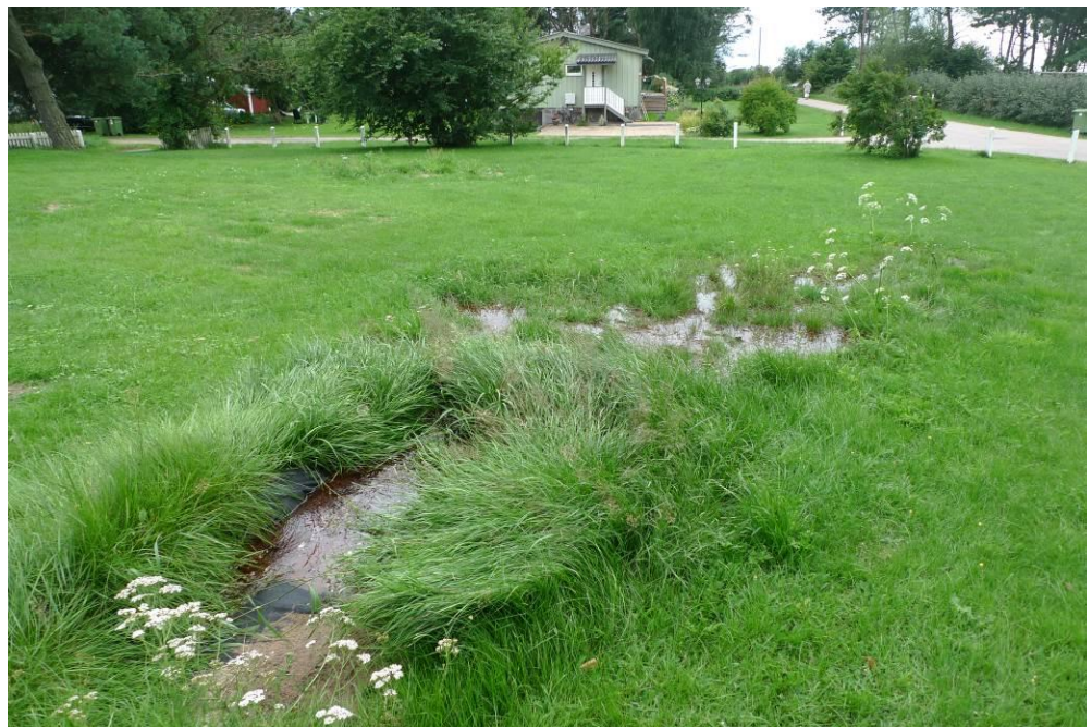
Bild 3.8: Utströmning från stenkista på fastigheten Ugglarp 3:25.
