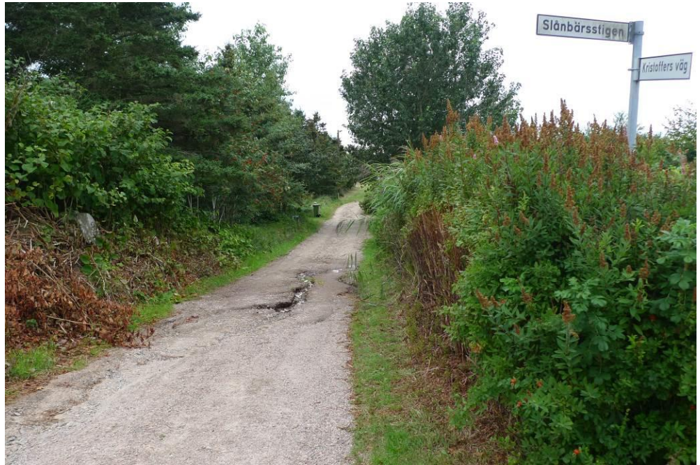
Bild 3.7: Utströmmande grundvatten och erosionsskador i Kristoffers väg.
