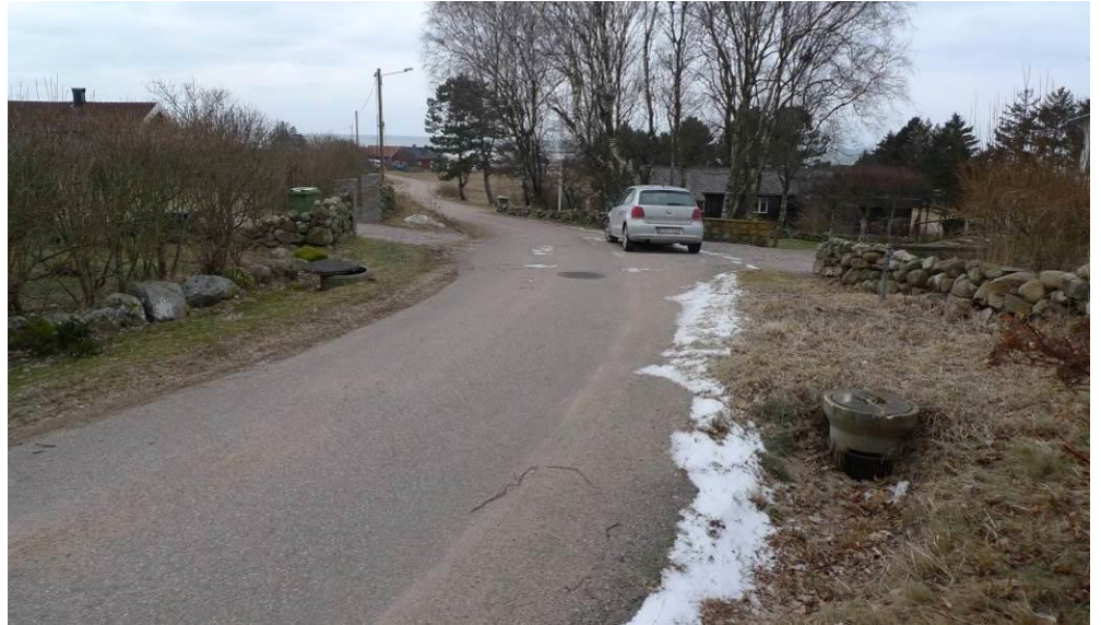
Bild 4.1: Dikesbrunn ansluten till dagvattenbrunn i Vassviksvägen.
