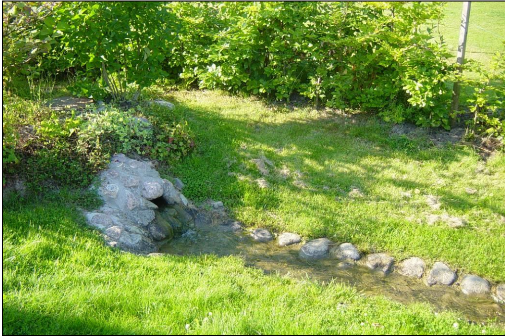
Figur 23. Stenklätt inlopp till dike/torr damm för fördröjning och erosionskydd, från Helsingborg (E. Nilsson-Keskitalo)
