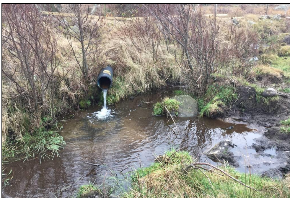
Figur 13. Diket kulverteras under en gårdsgård till en vattenansamling i dikessystemet inne på betesmarken
