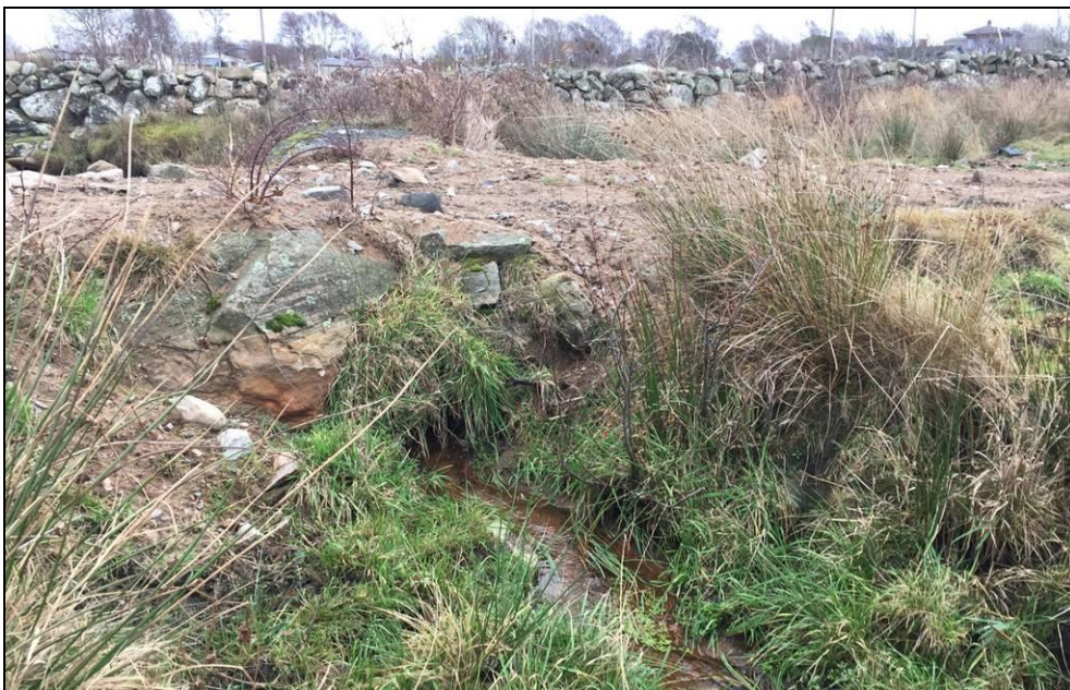
Figur 11. Nedströms grusvägen kulverteras diket under ytterligare en grusväg
