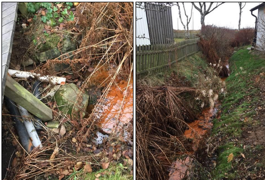
Figur 9. Dagvattenlednings utlopp till dike väster om stugområdet vid Tuvmarkstigen
