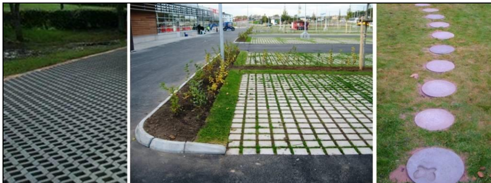
Figur 21. Ytor med hålsten av betong samt gångstig med gräs och gångplattor
