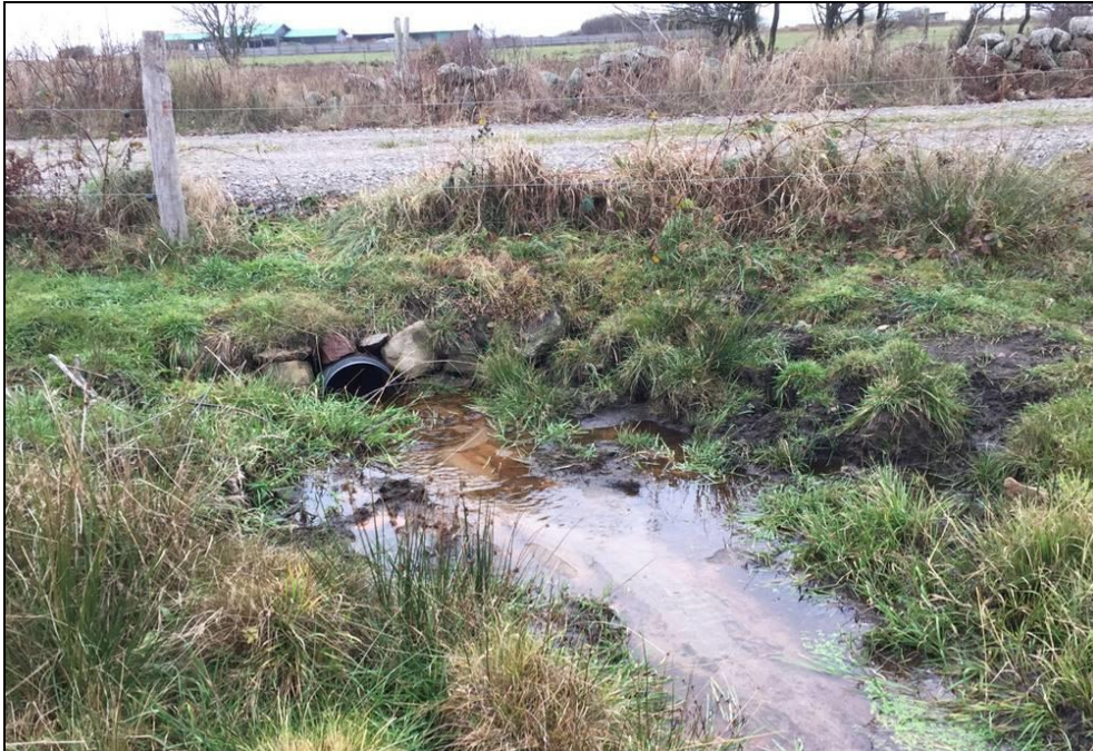
Figur 10. Diket kulverteras under en väg via en trumma av dimension 350 mm (PVC)
