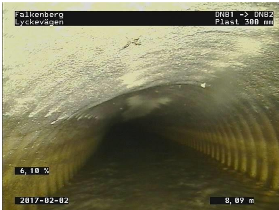
Figur 17. Punktdeformation ca 9 m nedströms brunn NBA 514 i D300 mm (DNB1 enligt filmprotokollet)
