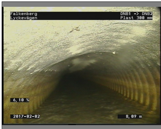
Foto: 3_4A, Media nr.: 020217_1, 00:01:10 8,09m, Deformation 4. Mer än 30% av rörets dimension, Punktdeformation.
