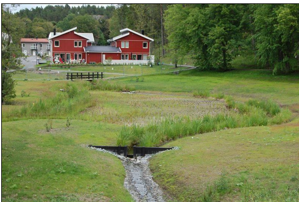
Figur 22. Översilningsyta med skibord i båda ändar och makadam i avrinningsstråk (VegTech)
