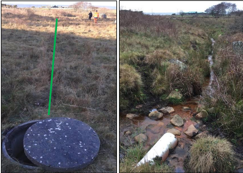
Figur 8. Brunn (t.v.) belägen utmed fastighetsgränsen nordväst om stugområdet varifrån en ledning avleder planområdets avrinning till diket inom nedströms fastighet (t.h.)
