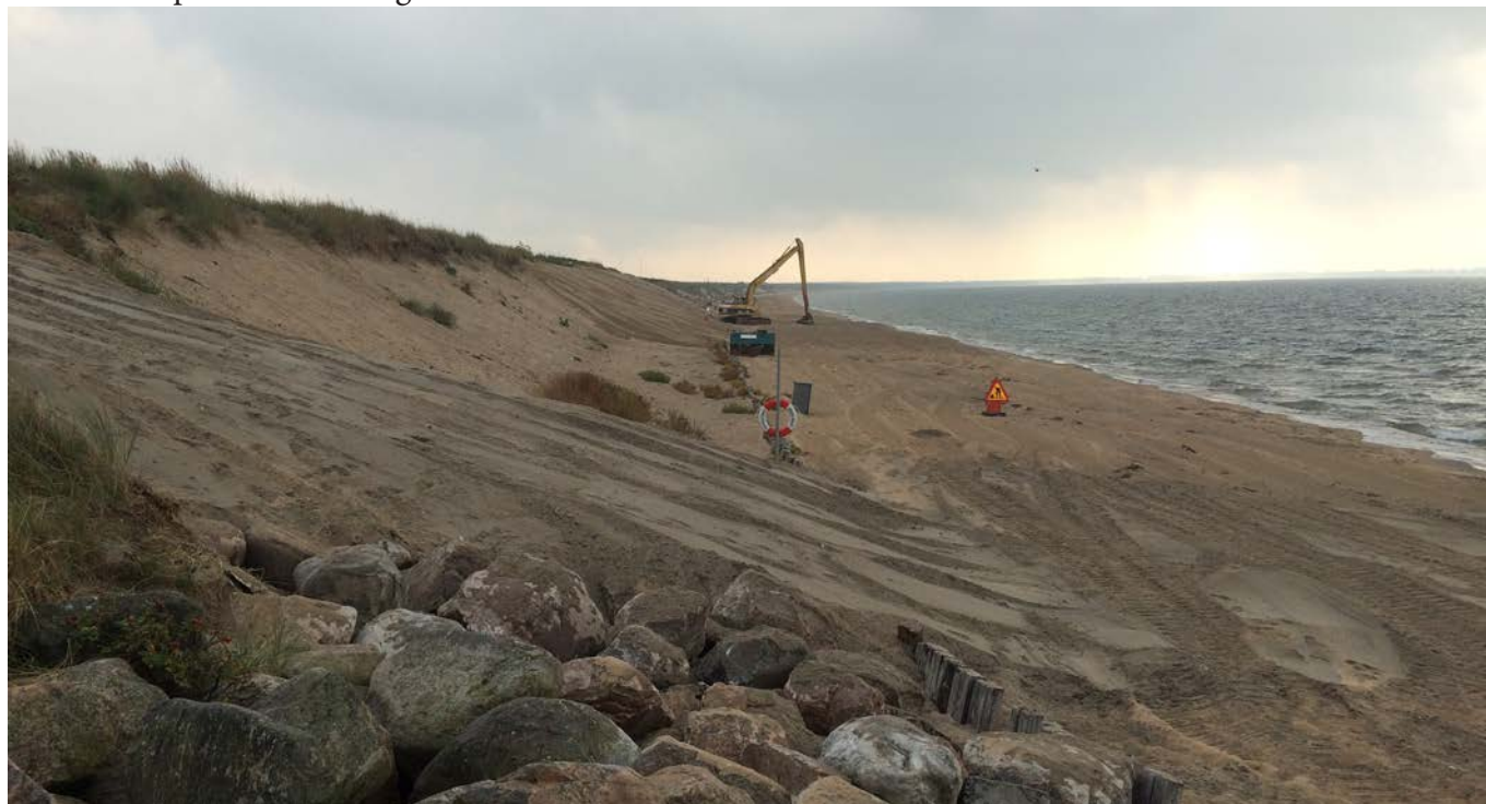
Bild 6 Ett exempel på åtgärd är hur man i Ängelholm återför sand till stranden, som annars försvinner. Man pratar även om storskalig sandsugning till havs.
